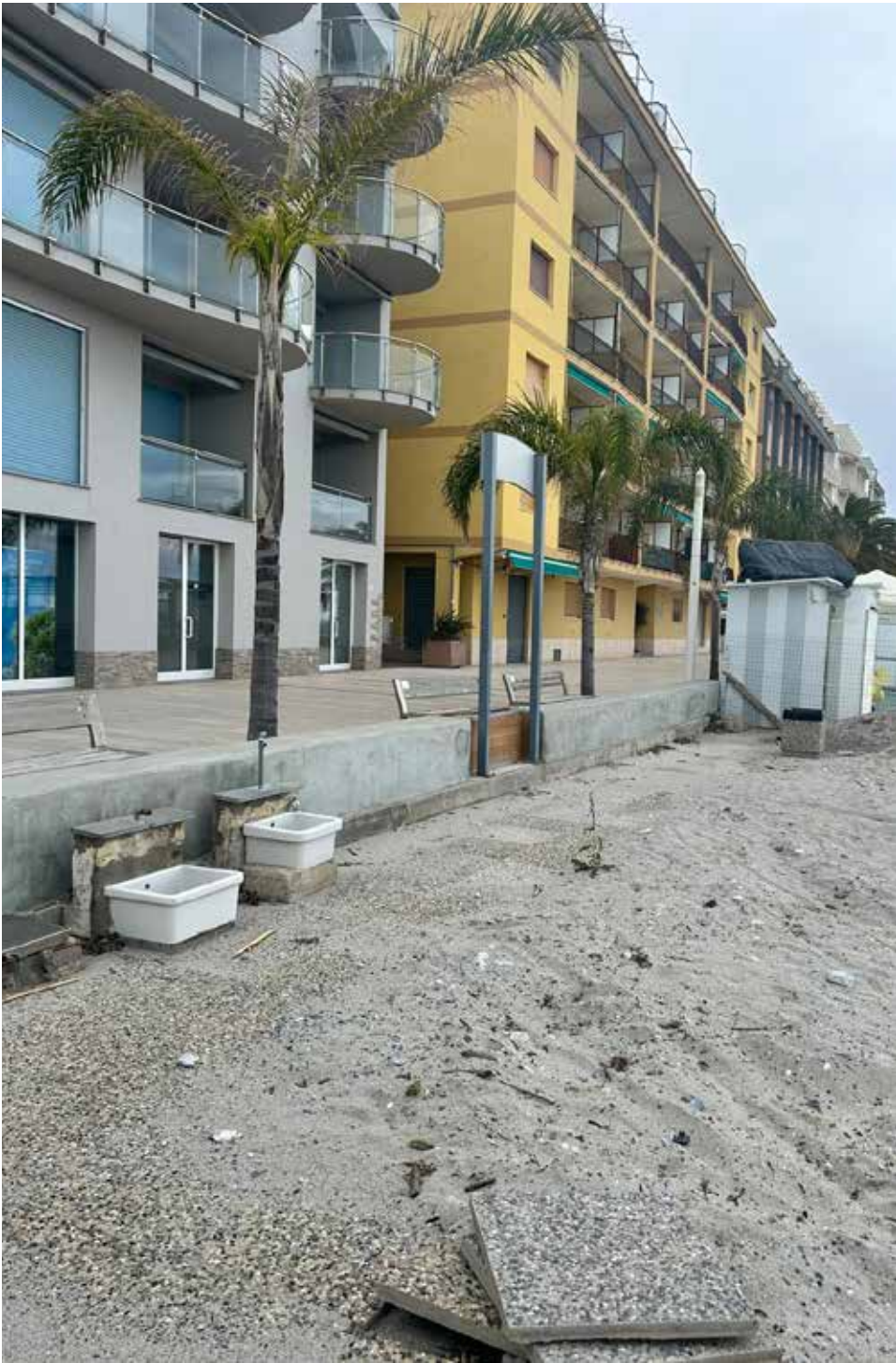
3 - Dettaglio del dislivello da risolvere.
