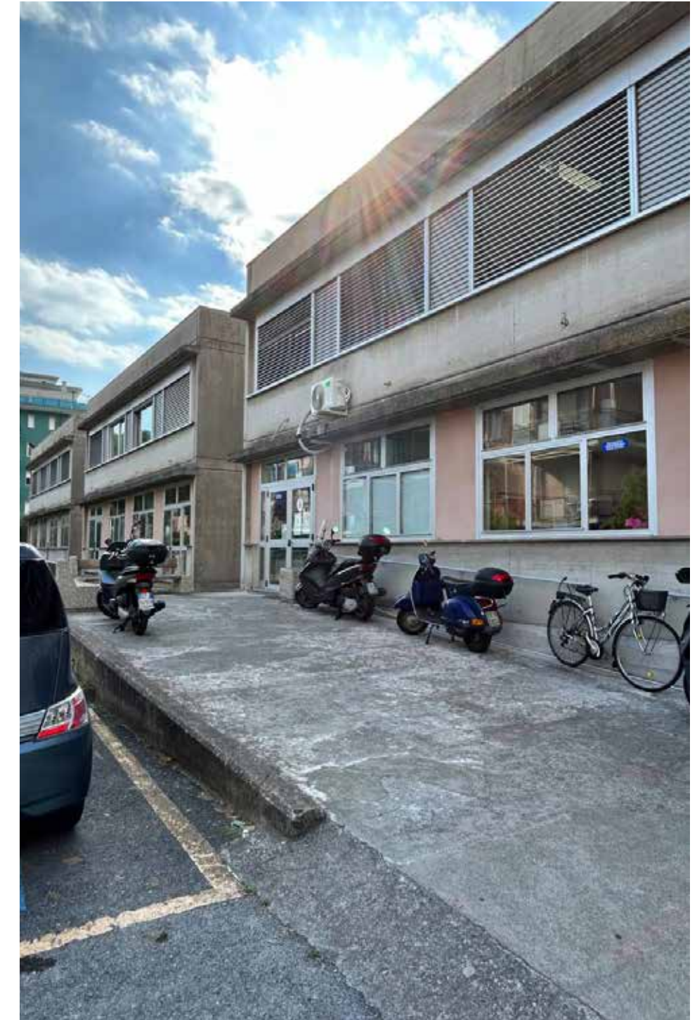
3 - Ingresso secondario dal parcheggio dotato di rampa con pendenza inferiore all'8%.
