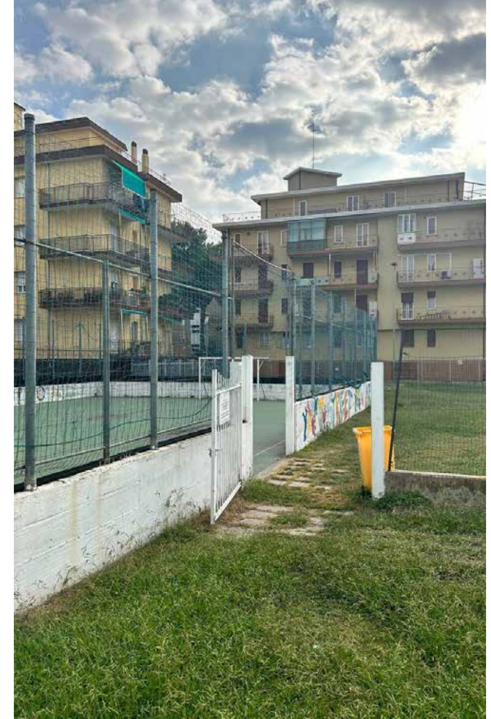
3 - Ingresso al secondo campetto sportivo. Pavimentazione discontinua.
