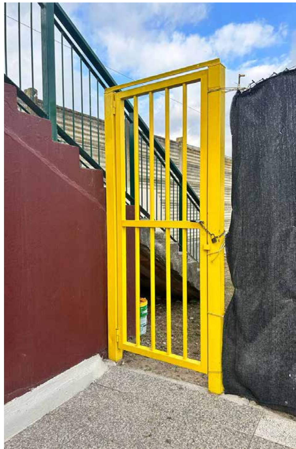
2 - Cancelli che porta ad una via di fuga.
