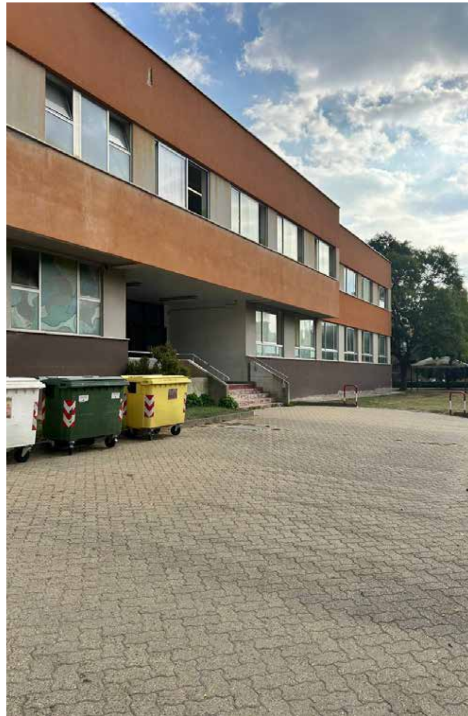
2 - Ingresso alla scuola primaria. Presenza di scale all'ingresso.
