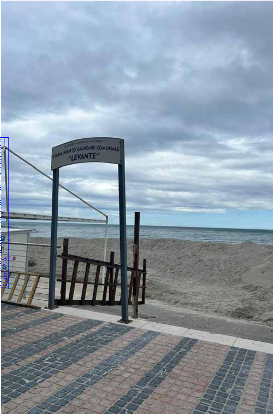
1 - Ingresso allo stabilimento balneare, presenza di rampa con inclinazione superiore all'8%.
