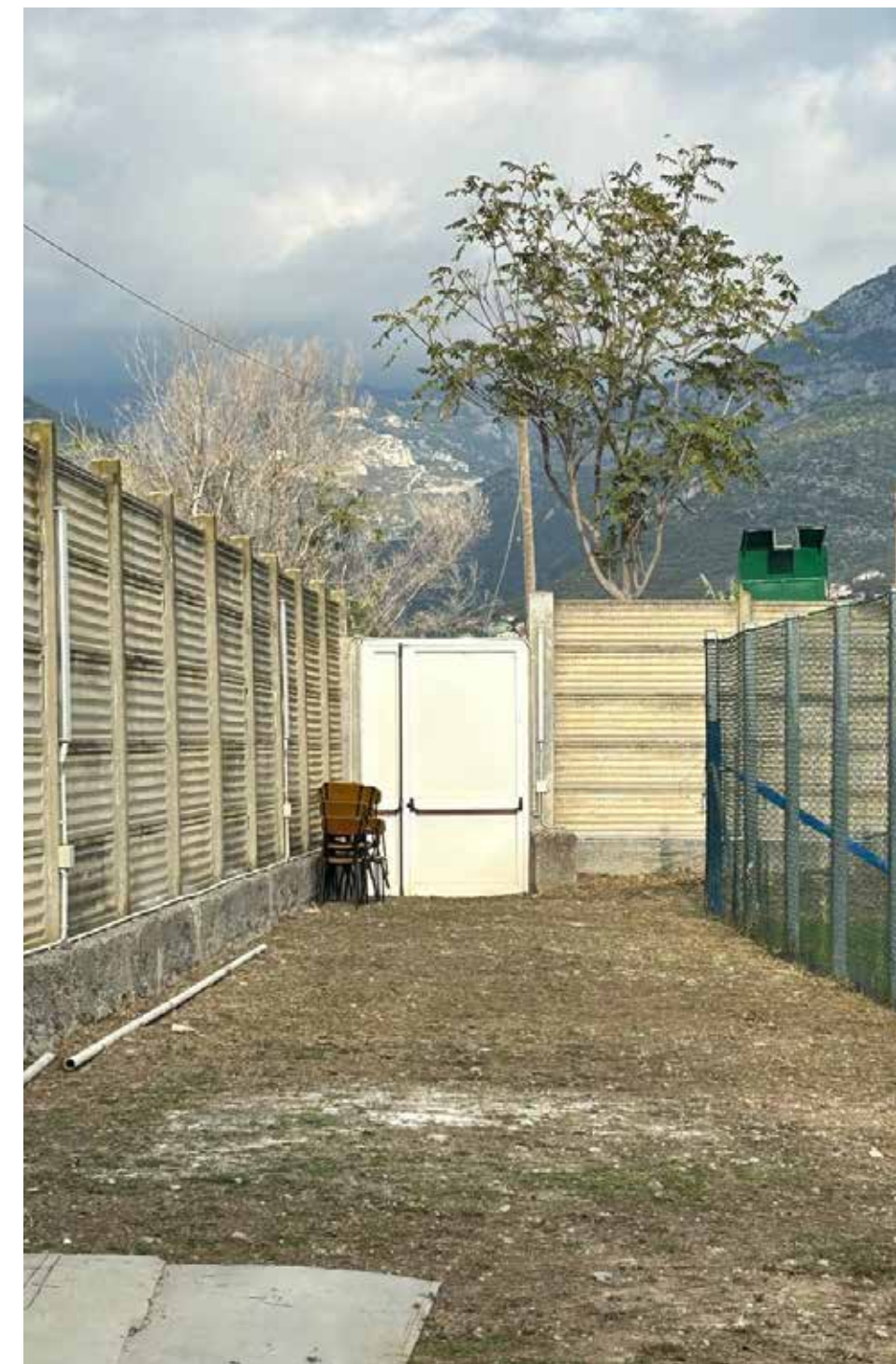
3 - Via di fuga con pavimentazione non continua.
