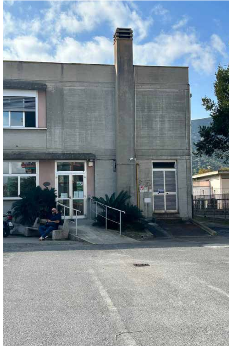
2 - Ingresso secondario dotato di rampa con pendenza inferiore all'8%.
