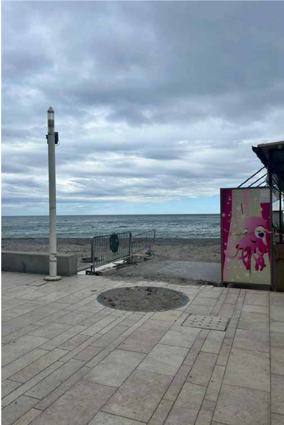
2 - Rampa di accesso alla spiaggia pubblica, assenza di elementi che permettano il passaggio sul terreno sabbioso.
