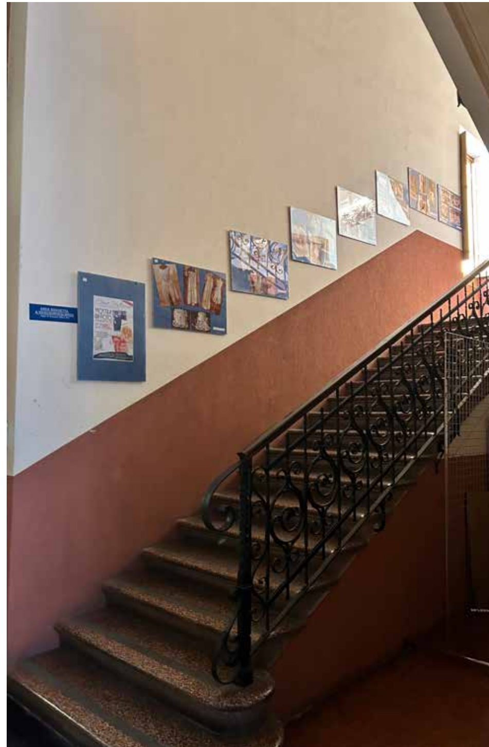
5 - Scala di collegamento al piano superiore.
