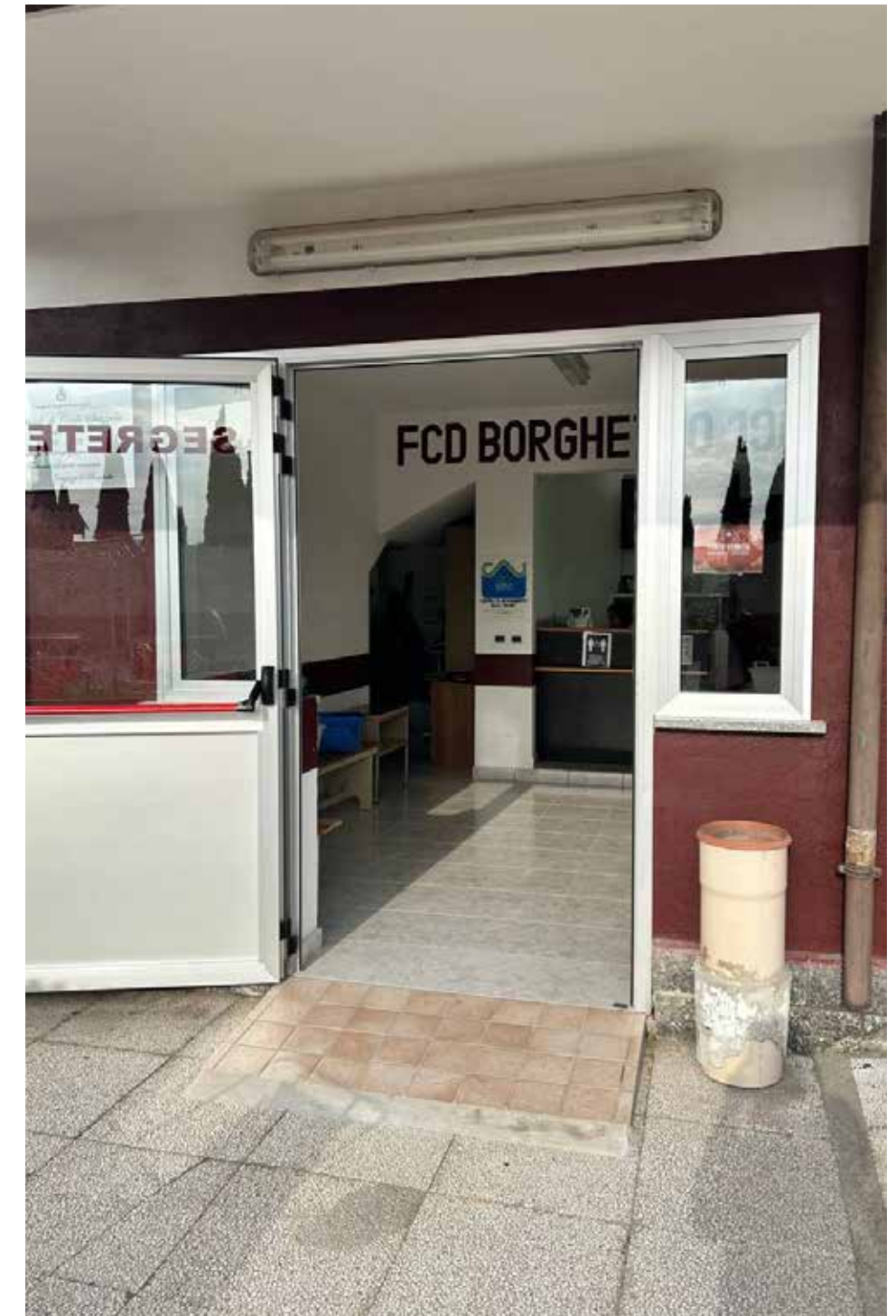
6 - Ingresso biglietteria dotata di rampa.
