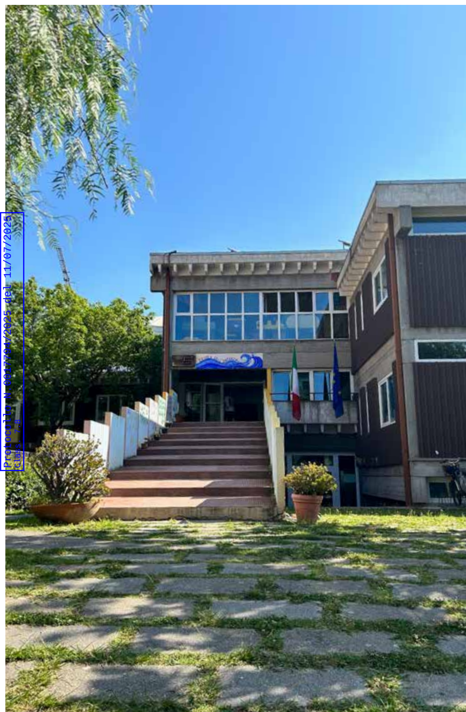
1 - Ingresso alla scuola d'infanzia. Presenza di scalinata all'ingresso.
