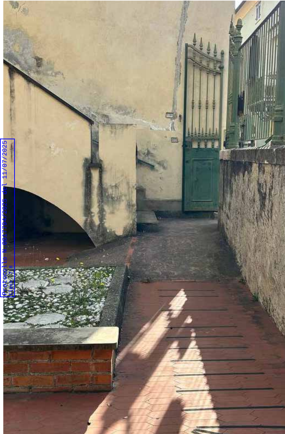
1 - Ingresso all'edificio. Accesso difficoltoso e stretto.
