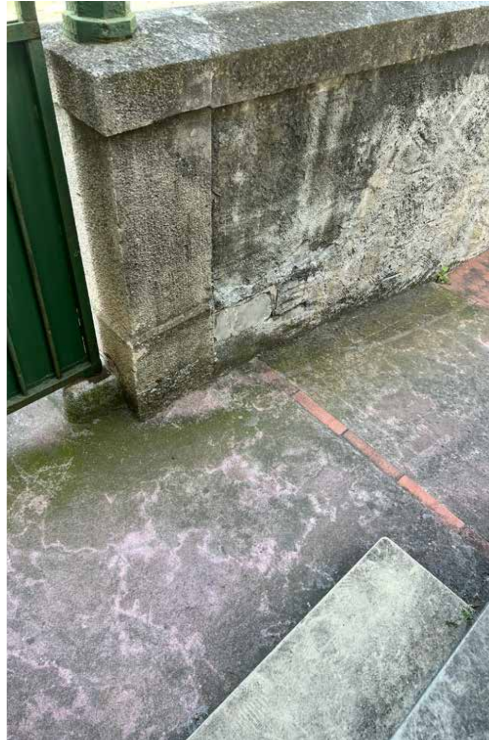
2 - Presenza di scale esterne che collegano il piano terra con il piano superiore.
