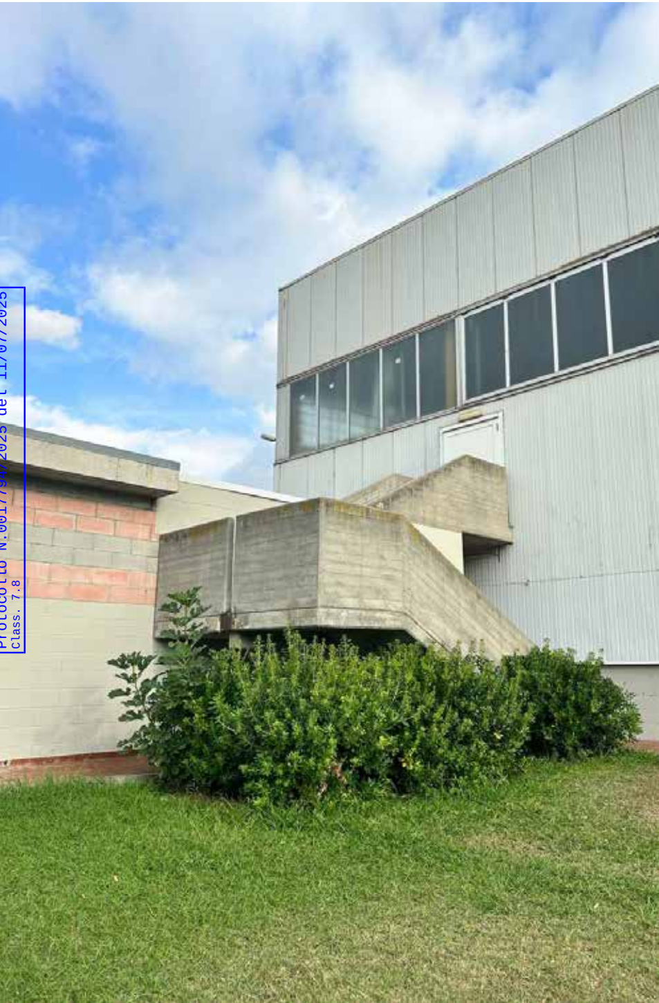
4 - Uscita di emergenza dalla struttura.
