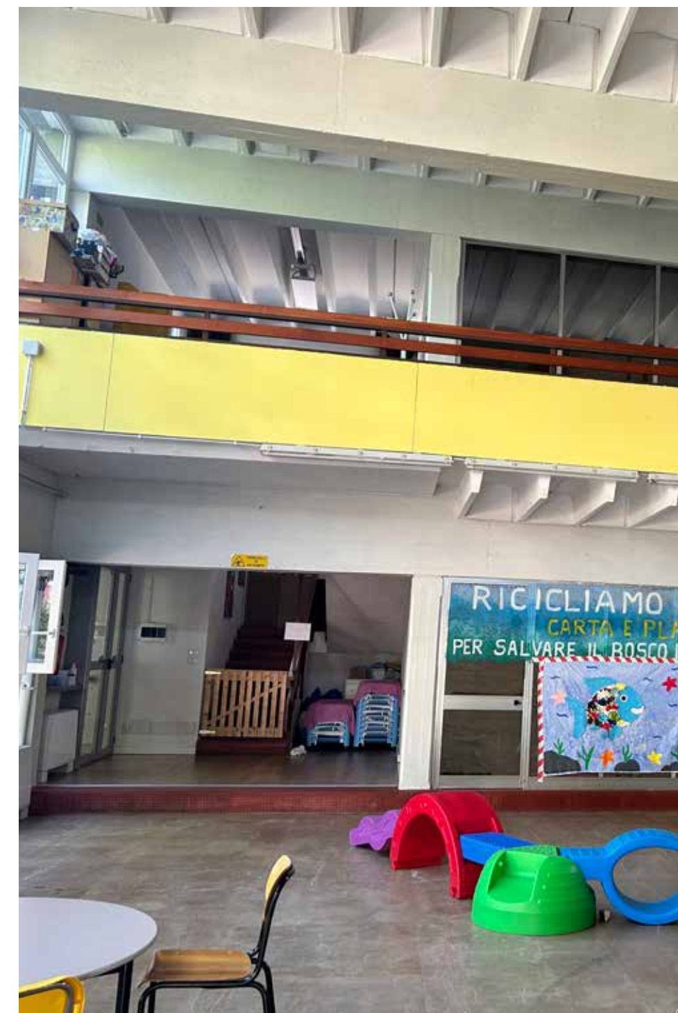
3 - Area accoglienza alunni. Presenta di un cordolo che divide due aree della scuola.
