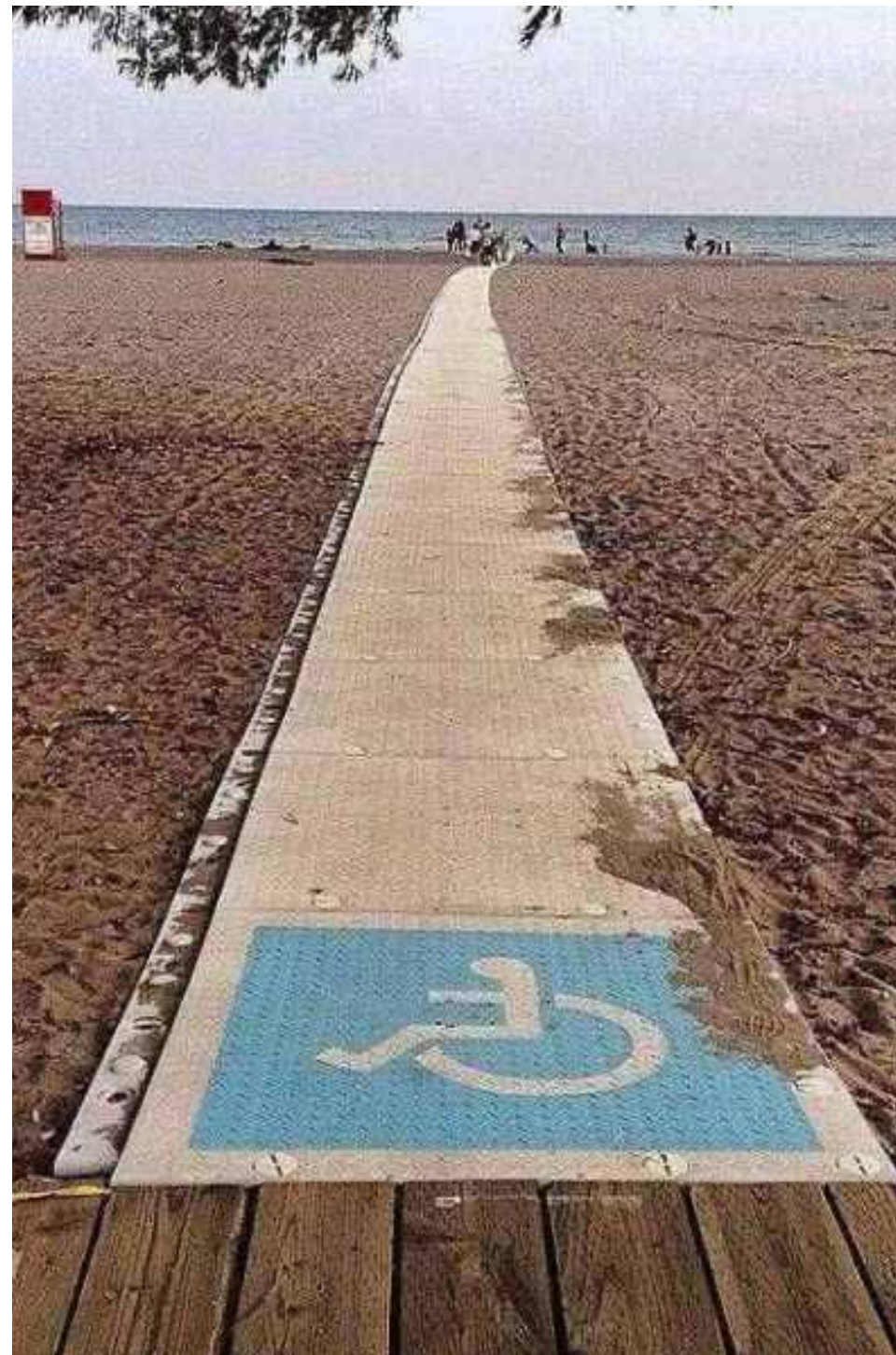
2 - Passatoia per agevolare l'ingresso e il raggiungimento della battigia con difficoltà ridotte
