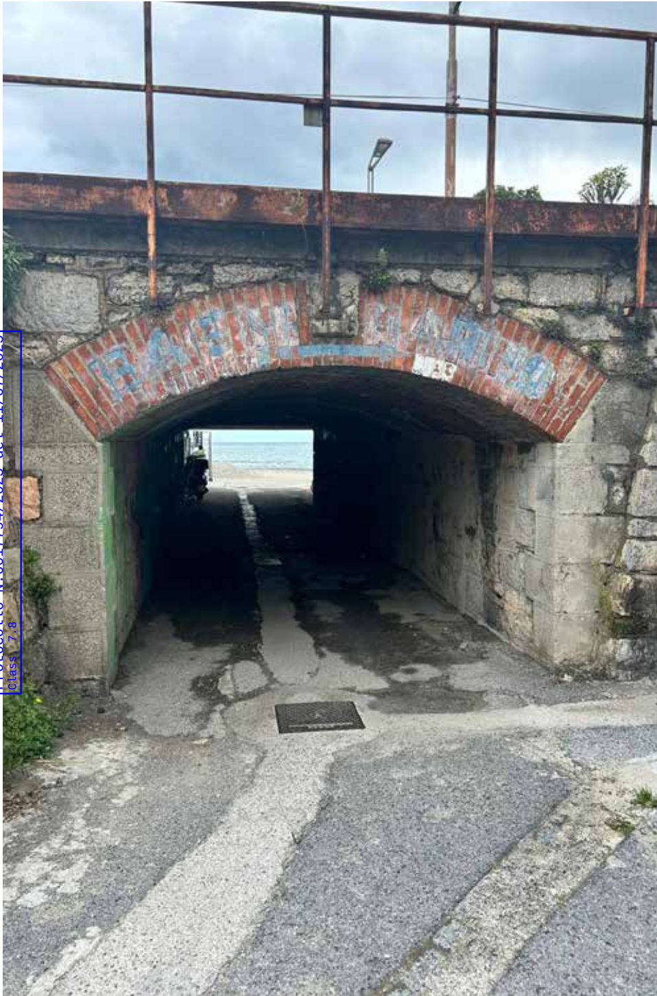
1 - Per accedere alla spiaggia comunale si deve percorrere un sottopasso ferroviario.
